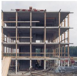
Haerle Hubacher, Balance, CH osature bois beton + extensions en metal
